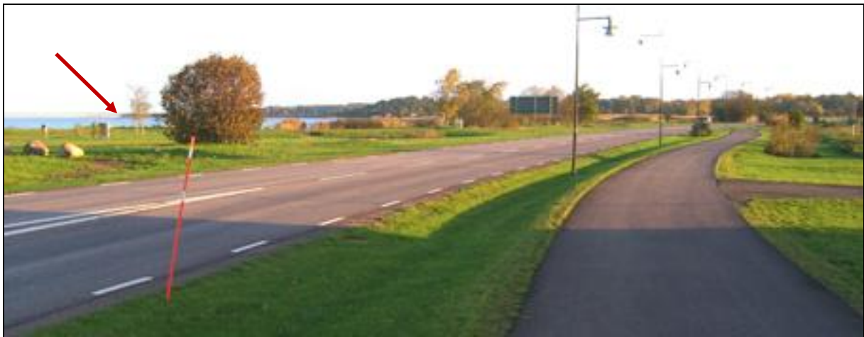
Brovägen i Färjestaden. Brofästet till Ölandsbron är beläget vid pilen där även bron skimtar. Foto: Lennart Ivarsson
