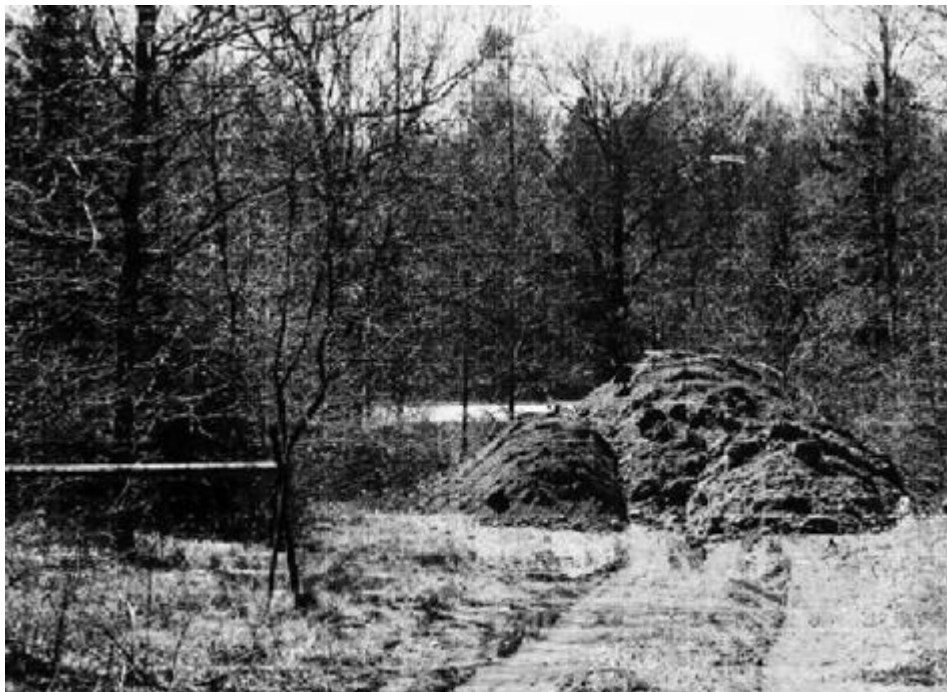
Norr om Ölandsbron har kommunen lagt massan som ska användas till den första bullervallen. Foto: Karoline Ödell
